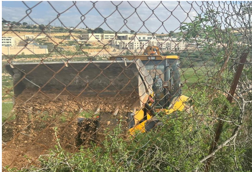
Bau einer Straße durch Siedler auf dem Land des Tent of Nations, Feb 2024
